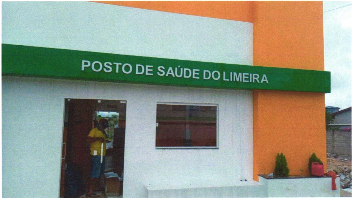
Foto 03 - Letra em alumínio 20 x 20cm - instalado
