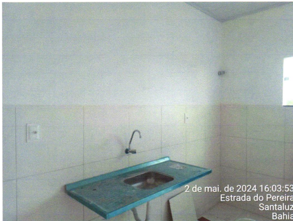
Foto 25 - Pia de cozinha com bancada em aço inox, dim 1,20x0,60m c/ 01 cuba, válvula cromada, sifão cromado e torneira cromada, concretada e assentada. Rev.04
