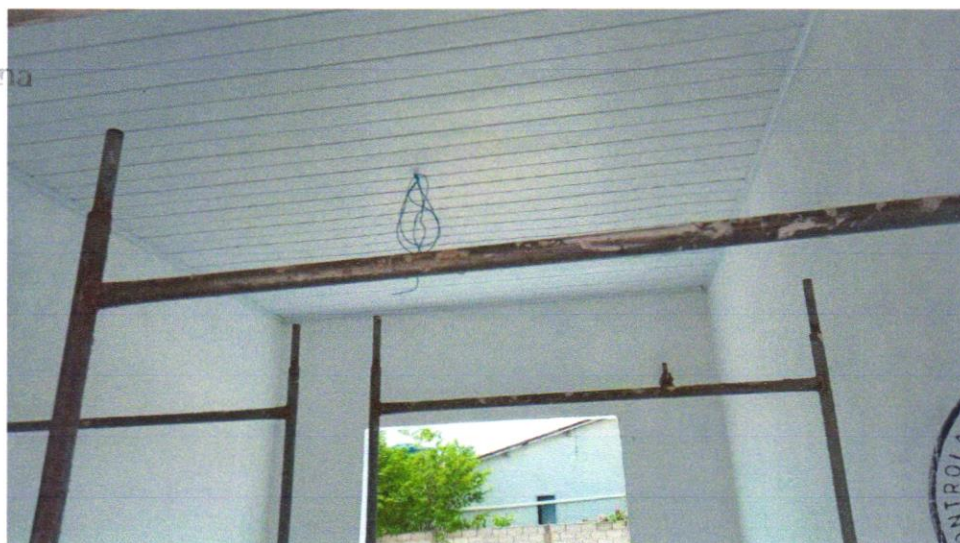
Foto 24 - CABO DE COBRE FLEXÍVEL ISOLADO, 2,5 MM 2 , ANTI-CHAMA 450/750 V, PARA CIRCUITOS TERMINAIS - FORNECIMENTO E INSTALAÇÃO. AF_12/2015
