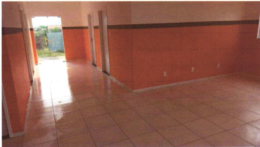
Foto 07 - APLICAÇÃO MANUAL DE PINTURA COM TINTA LÁTEX ACRÍLICA EM PAREDES, DUAS DEMÃOS. AF_06/2014
