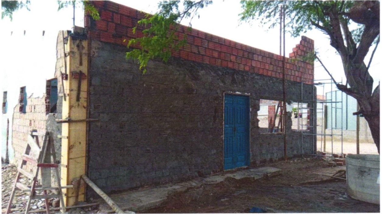
Foto 21 - CHAPISCO APLICADO EM ALVENARIA (COM PRESENÇA DE VÃOS) E ESTRUTURAS DE CONCRETO DE FACHADA, COM EQUIPAMENTO DE PROJEÇÃO. ARGAMASSA TRAÇO 1:3 COM PREPARO EM BETONEIRA 400 L. AF_06/2014
