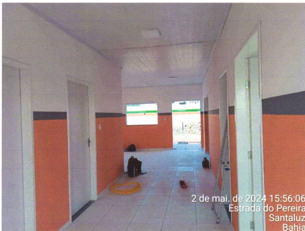
Foto 23 - KIT DE PORTA-PRONTA DE MADEIRA EM ACABAMENTO MELAMÍNICO BRANCO, FOLHA LEVE OU MÉDIA, 90X210, EXCLUSIVE FECHADURA, FIXAÇÃO COM PREENCHIMENTO TOTAL DE ESPUMA EXPANSIVA - FORNECIMENTO E INSTALAÇÃO. AF_12/2019
