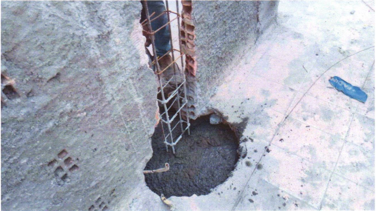
Foto 19 - (COMPOSIÇÃO REPRESENTATIVA) EXECUÇÃO DE ESTRUTURAS DE CONCRETO ARMADO, PARA EDIFICAÇÃO HABITACIONAL UNIFAMILIAR TÉRREA (CASA EM EMPREENDIMENTOS), FCK = 25 MPA. AF_01/2017
